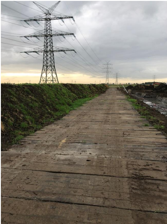
Oberbodenlagerung mit Lastenverteilungsmatten
