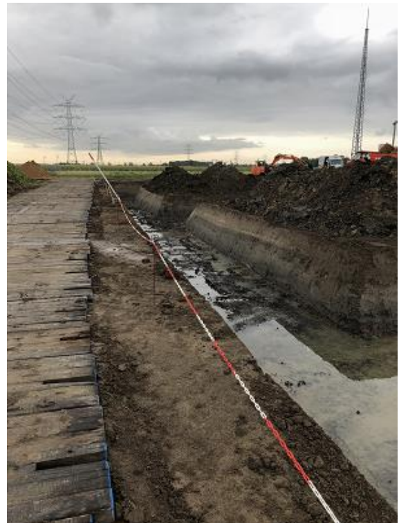
Kabelgraben mit Lagerung des Unterbodens
